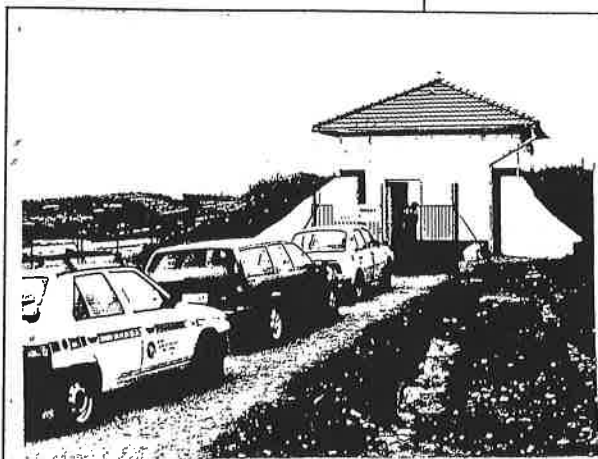
Snímek se vracíme ke kolaudaci vodojemu Řimice.
